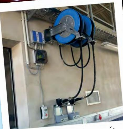
Ölabgabeeinheiten mit Zeitsteuerungssystem
